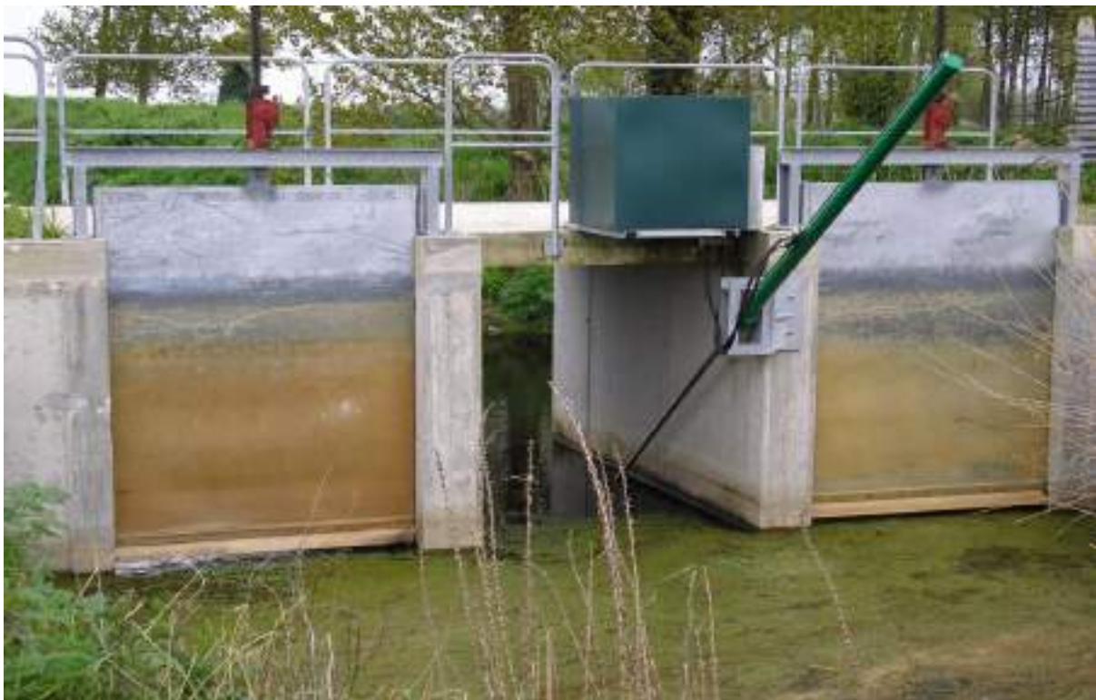
Photo 1 : Vannage de St-Guinoux
